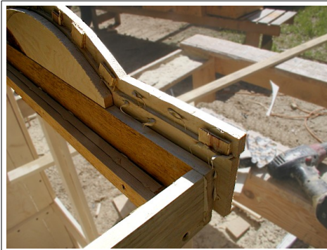
Le rebord découpé est recollé en place avec les cales.
