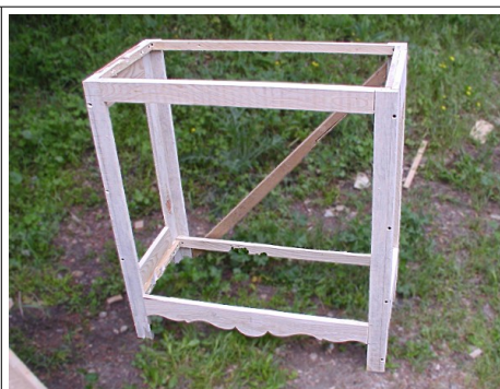
Le cadre de la façade en place.
