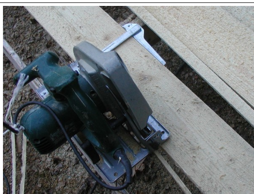
Délimitage des voliges à 12cm de large avec la scie circulaire.
